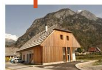
Dom trebarskih vodnikov
