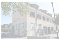
2020.03.16 Community Hall Zwischenwasser Austria
